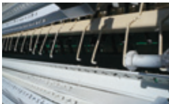
Montages d'accroche avant décapage.
